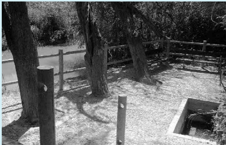
Estado actual de la Fuente de la Teja, junto al río Cubillas, en Valderrubio.
