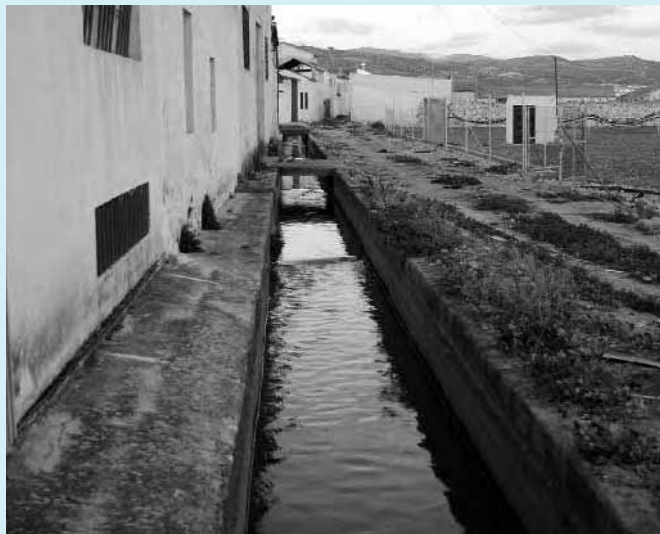
Acequia en Valderrubio.
